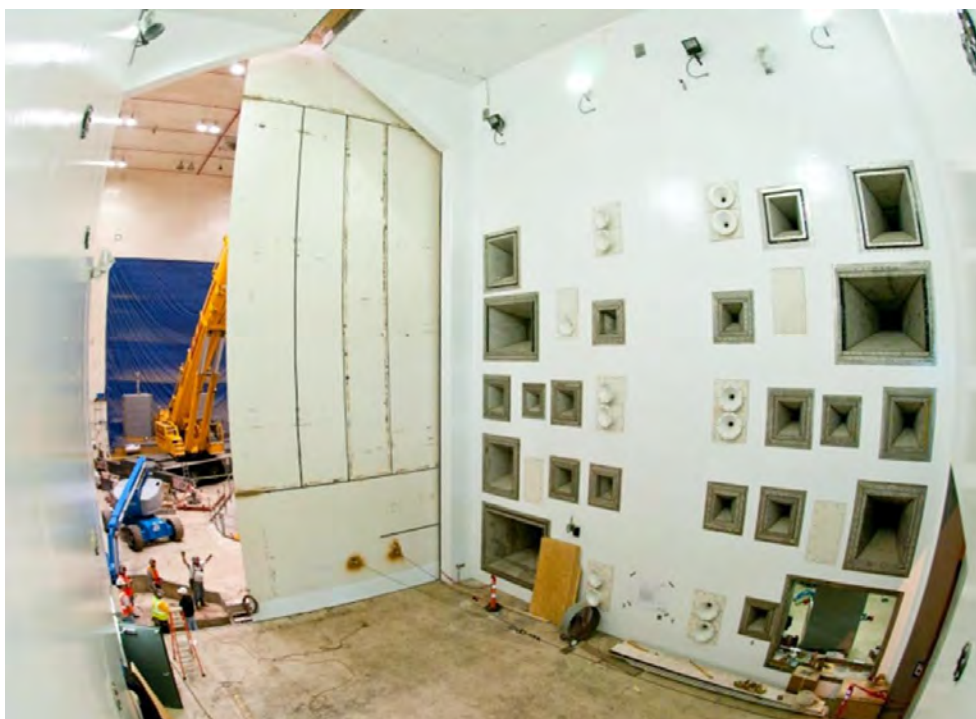
Figura 7.6 - Instalação da porta principal na RATF
