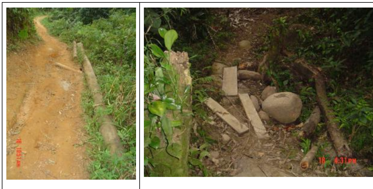
Figura 12 – Obstáculos que influenciam a estética e a segurança do visitante, requisitando a necessidade de corrimãos ou embelezamento.
