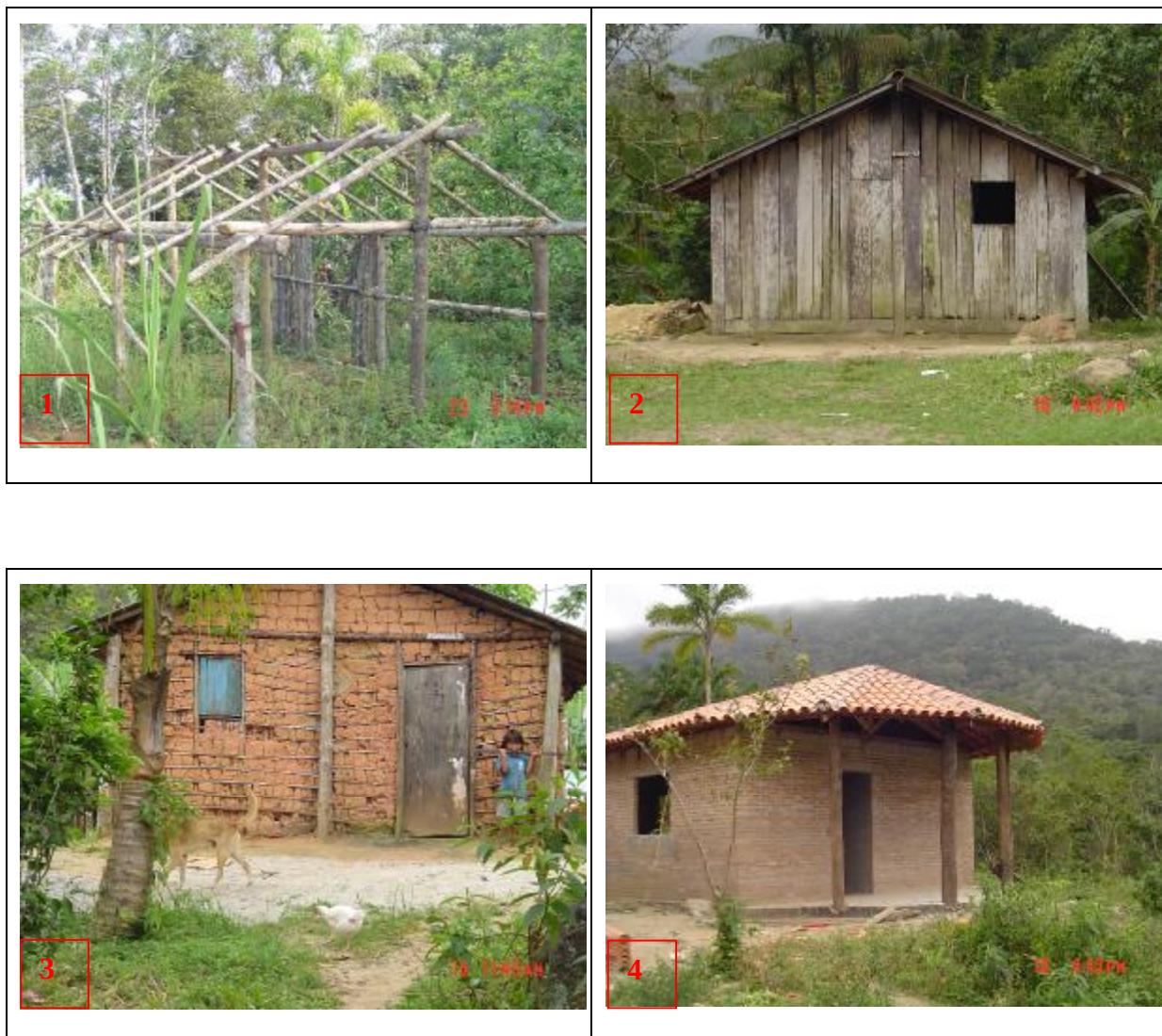
Figura 11 – Padrões arquitetônicos presentes na Aldeia: 1 – Construção tipicamente Guarany; 2 – Madeira; 3 – Taipas; 4 – Padrão utilizado pelo Projeto de construção de novas habitações.
