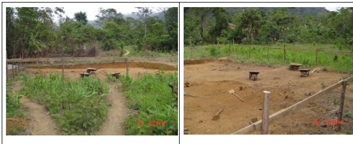
Figura 09 – Casa de Cultura em fase de construção.
