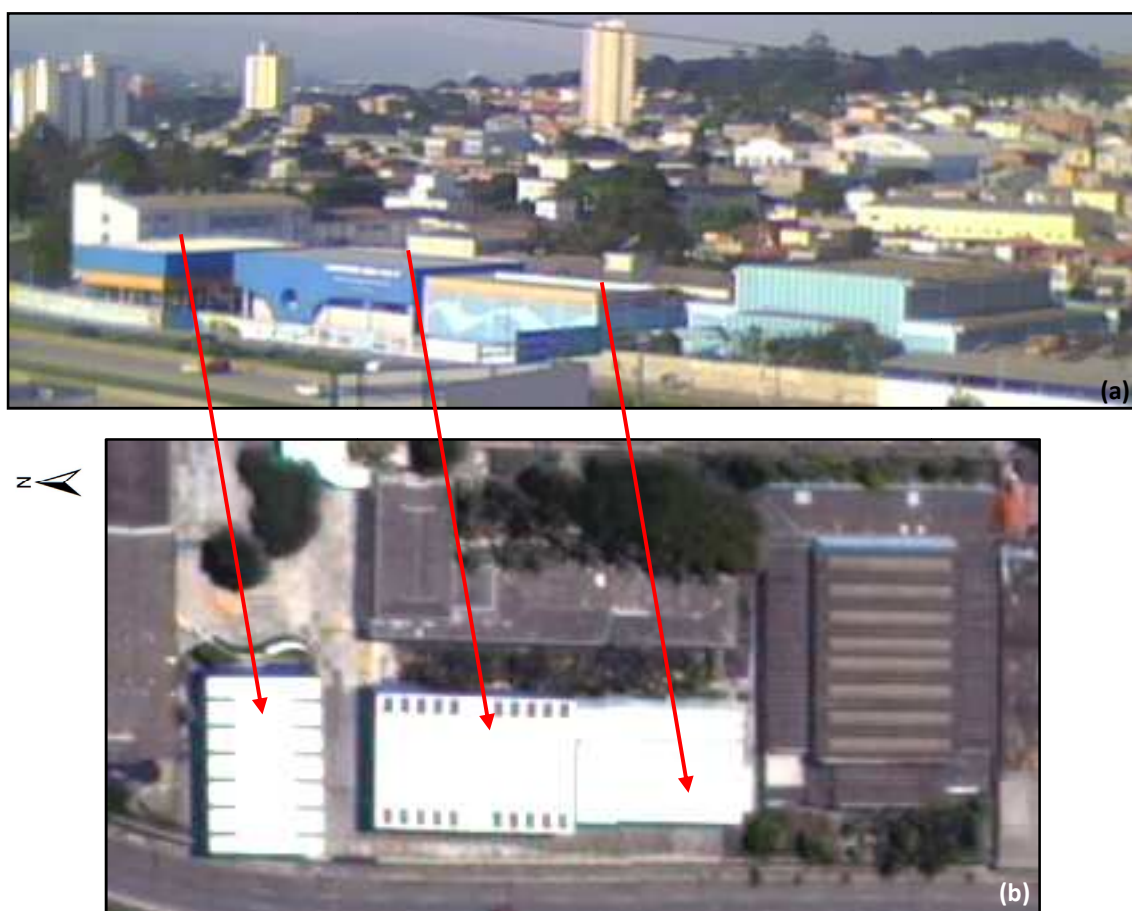
Figura 4.25 – Telhados metálicos planos da área-teste E.
