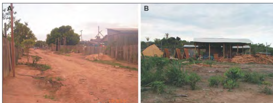
Figura 5.2.2.1.2 – Castelo dos Sonhos: A) Aspecto parcial da ocupação na comunidade, e B) madeireira.
