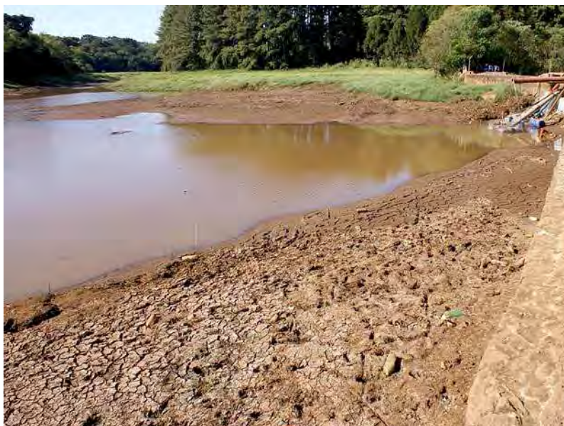
Figura 1.2 - Barragens, açudes e rios em Chapecó praticamente secaram no início de 2009 devido à estiagem.
