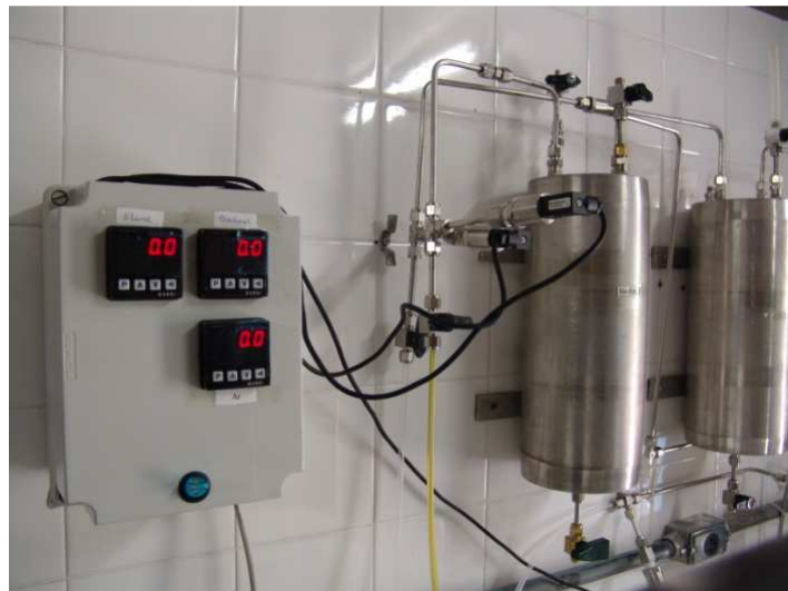
Figura 4.8 - Tanques de armazenamento de líquidos.
