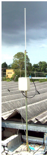
Figura 2.2 – AP instalado no alto de um prédio da UFPA
