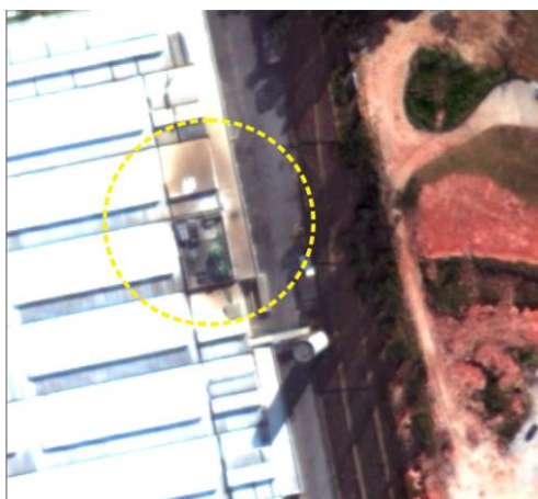
Figura 5.23 - Exemplo de cobertura metálica apresentando diferentes estados de conservação.
