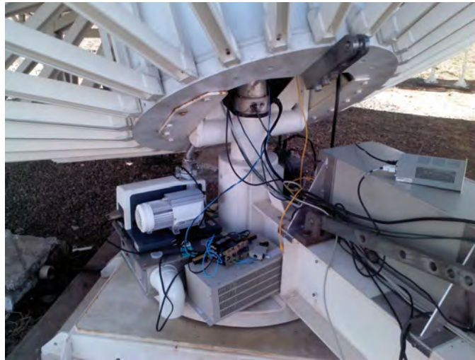
Figura 8.6 - Arranjo instrumental na base da antena
