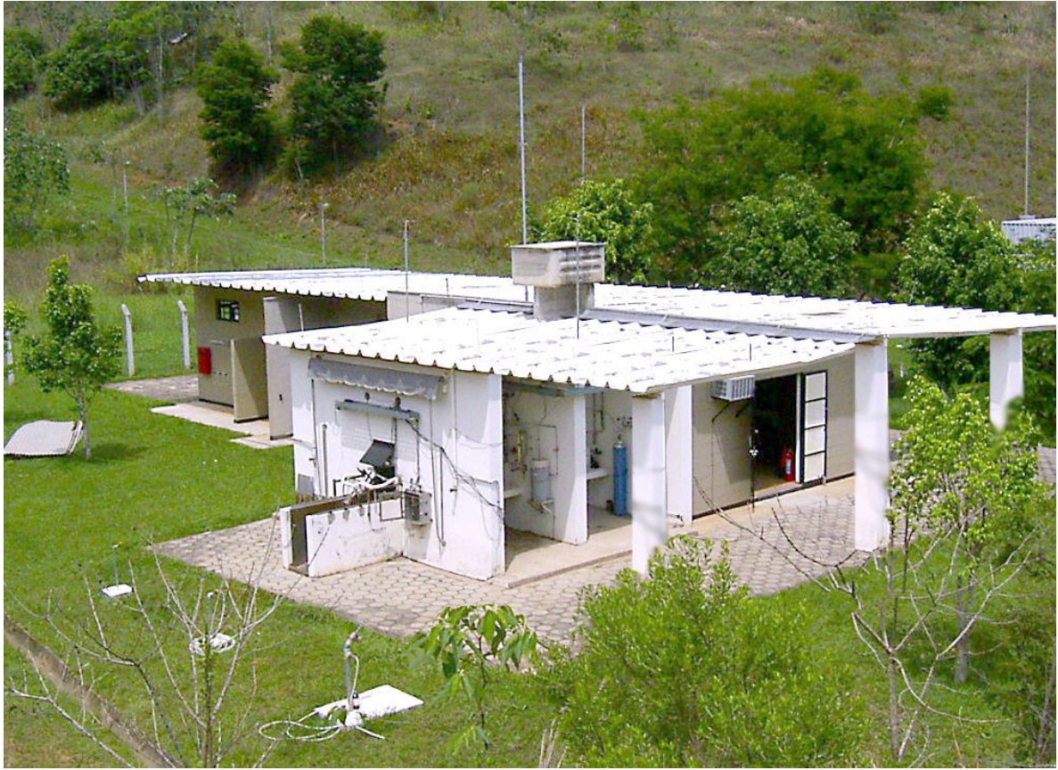
Figura 1.1 - Vista geral do BTCA.
