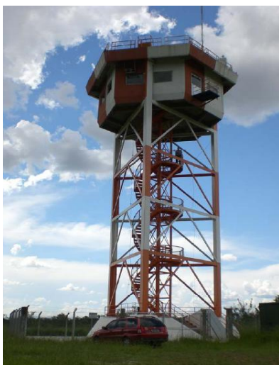
Figura 3.1 - Torre de observação de raios em São José dos Campos.
