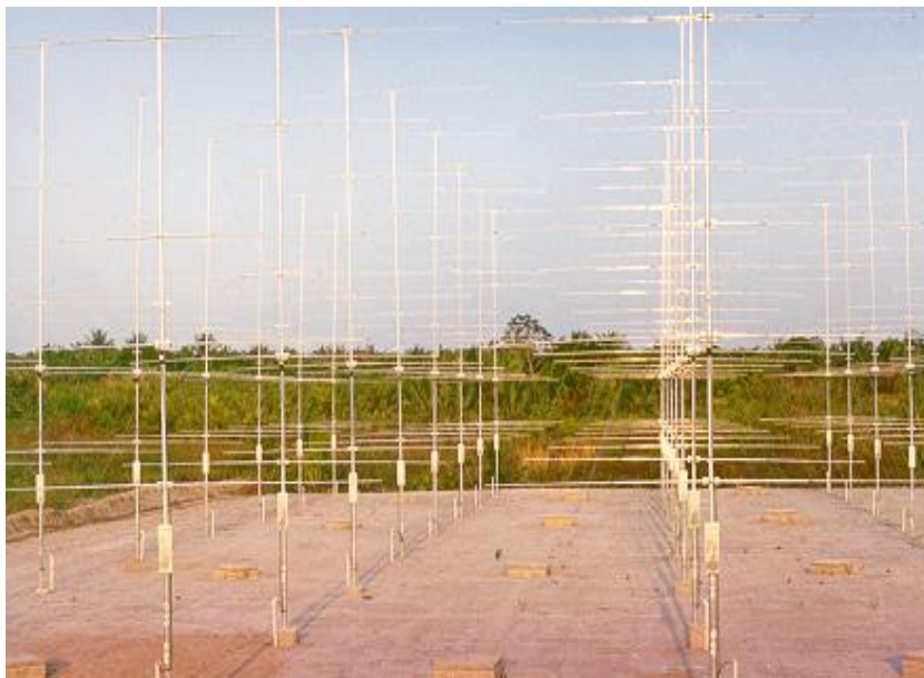
Figura 2 – Antenas do radar
