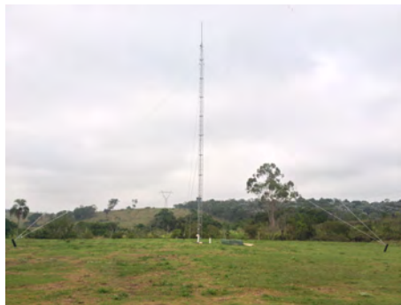
Figura 2.7 - Antena de transmissão e recepção da CADI instalada em São José dos Campos.
