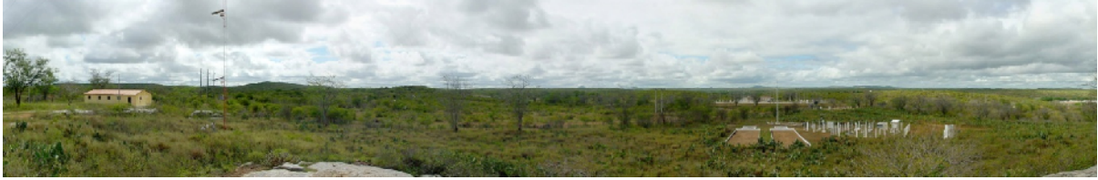
Figura 2.1 - Vista para o quadrante SE da torre de São João do Cariri - PB.
